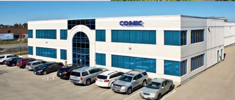
CONEC Canada, Brampton
