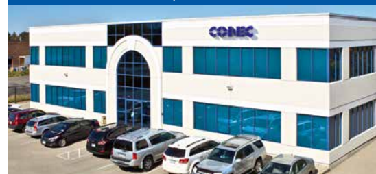
CONEC Canada, Brampton
